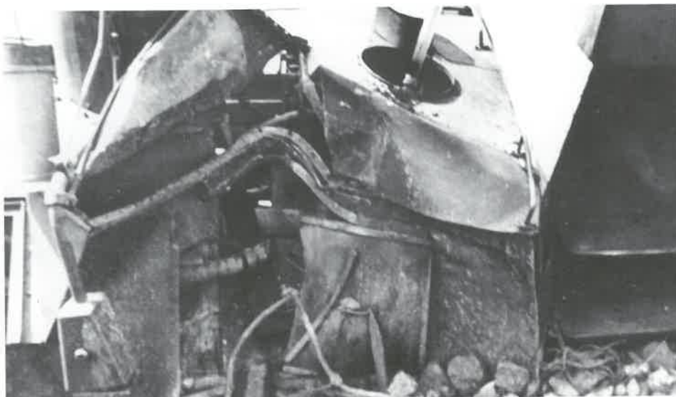
Bałtyk po kolizji z promem Neufährwasser . Inne ujęcie uszkodzeń holownika po kolizji z 1936 r. Zdjęcia wykonane dla potrzeb gdańskiej policji portowej (Hafenpolizei).
