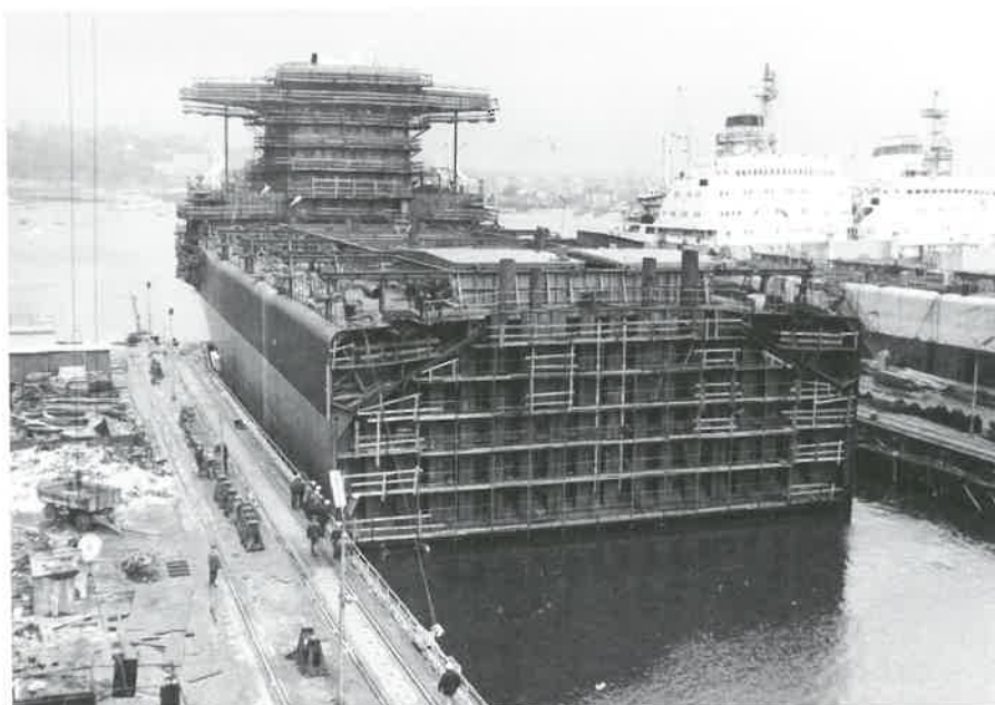
11 listopada 1969 r. – wyprowadzanie z doku rufowej połówki masowca.
