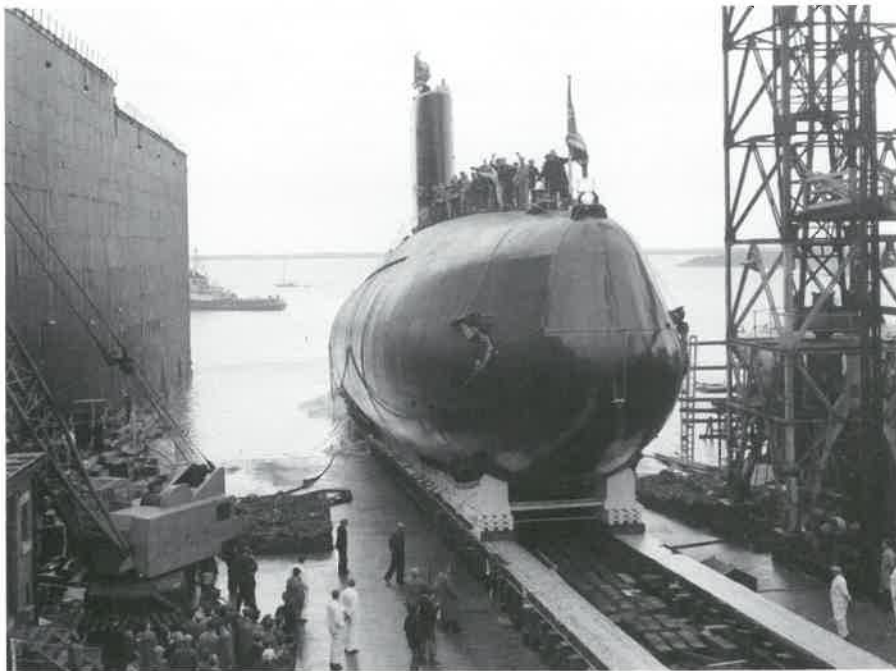
21 października 1960 r., kadłub Dreadnoughta schodzi z pochylni stoczni w Barrow-in-Furness. W trakcie tego procesu nie miał on sterów głębokości – ani dziobowych, ani rufowych, a także śruby.
